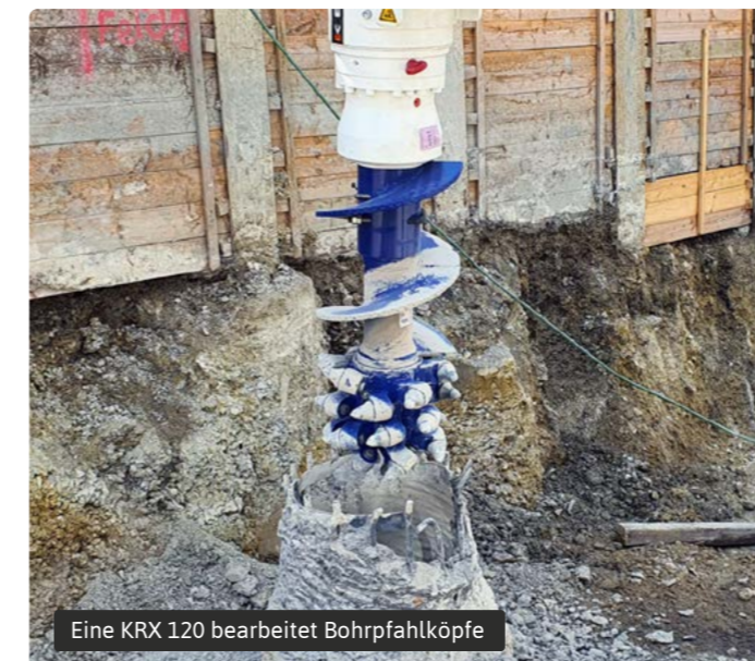
Eine KRX 110 beim Kappen von Bohrpfählen
