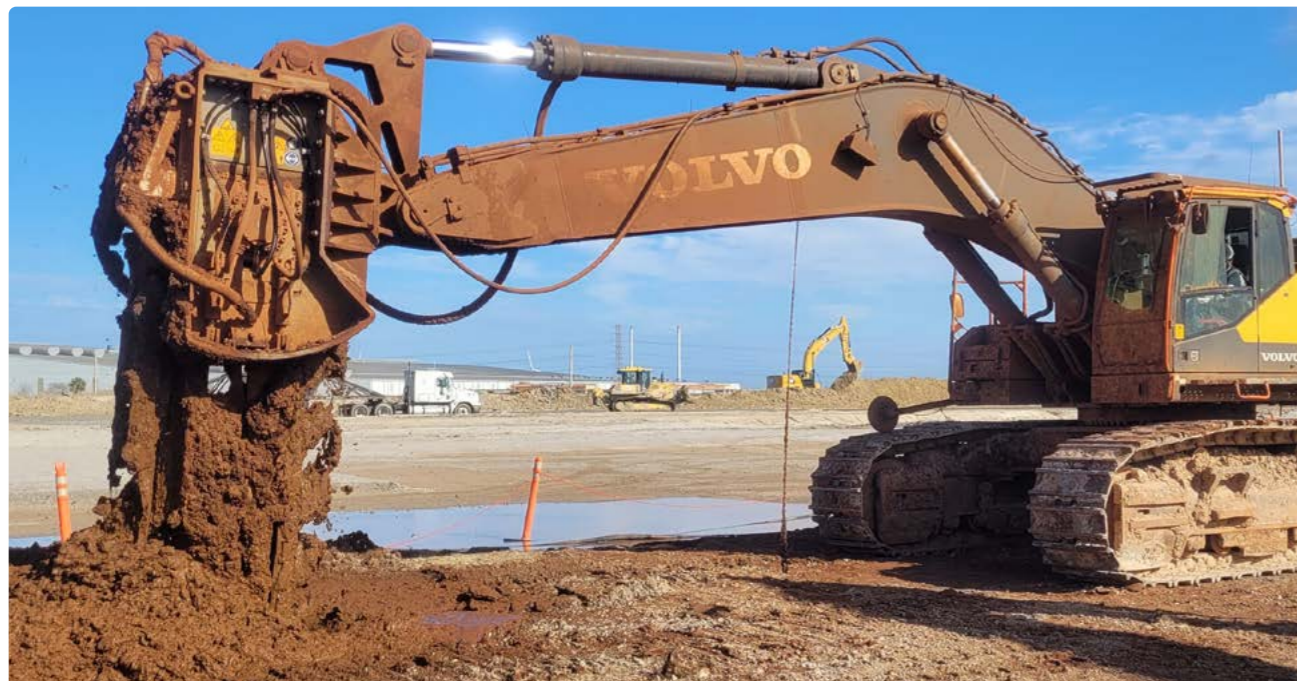
Eine KSI 12000 bei der Erstellung eines Erdbetonkörpers
